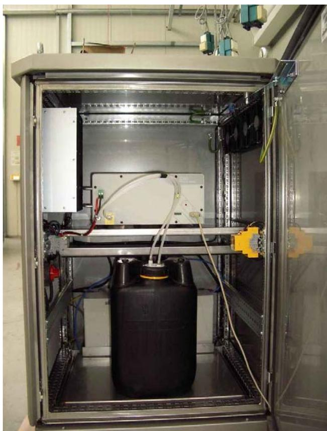
Das Back Pack System besteht aus einem Spritzwasser-geschütztem Schrank von Rittal. Darin integriert ist im Wesentlichen das iGen™ Brennstoffzellen System von IDATECH, die Batterie von Hoppecke, ein Inverter von Innecken, Tanks mit einem Methanol / Wassergemisch von Brenntag und weitere elektrische Steuer- und Sicherheitskomponenten von anderen Zulieferern.
