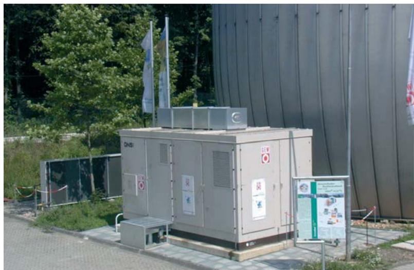
**Abbildung 4.10:** Brennstoffzellenanlage mit einer elektrischen Leistung von 200 Kilowatt
