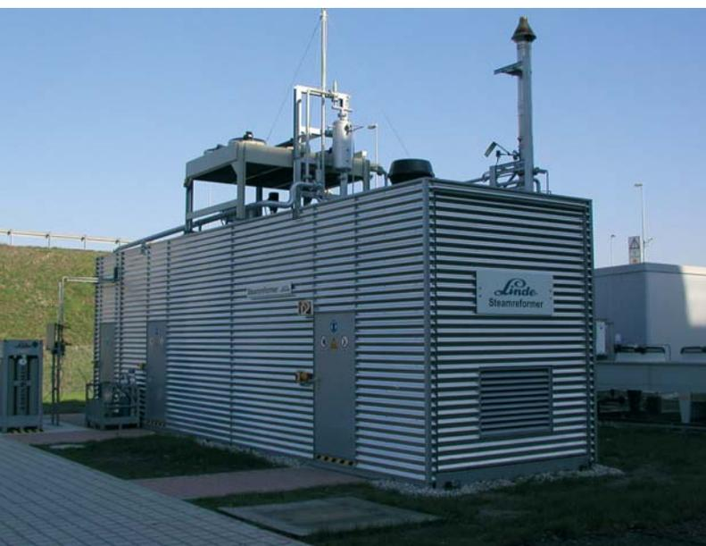
**Abbildung 2.5:** Hydrogen Compact Generator - HCG
